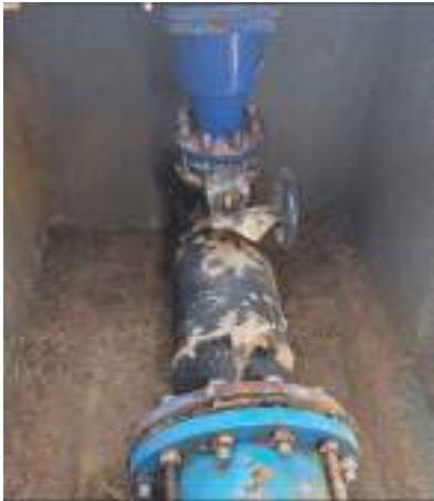
Foto12. 20240318_Pozo 1° Finca C detalle
